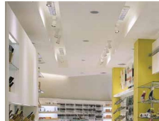
paredes e amplia visualmente o espaço. Essa luz difusa é alcançada por meio de lâmpadas fluorescentes tubulares T5 de 28W, na temperatura de cor 3000K, instaladas em sancas com proteção visual em acrílico translúcido enquanto a iluminação geral é através de luminárias com louver parabólico, para eliminar o ofuscamento direto e para o mesmo tipo de lâmpada. “Uma das exigências era flexibilidade no projeto de iluminação, baixo consumo de energia e pouca manutenção.”
